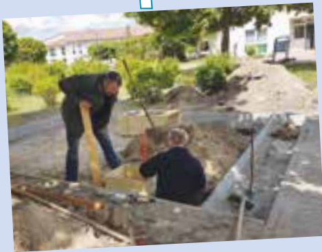
Große Freude! Die baulichen Vorarbeiten für unsere Rollstuhlschaukel haben begonnen. Die Einweihungsfeier findet im Juni statt.
